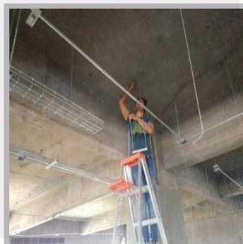
La segunda parte del trabajo consiste en la colocación y el peinado de los cables en las canastillas instaladas, los cuales transmitirán internet a los nodos solicitados para la planta alta del edificio.
