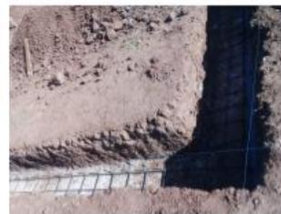
SUMINISTRO Y COLOCACIÓN DE ESTRUCTURA METÁLICA A BASE DE VARILLA DE 1/2"
