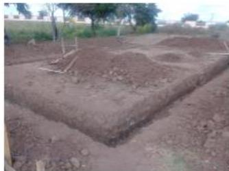
EXCAVACIÓN PARA CIMENTACIÓN (ZAPATA CORRIDA)
