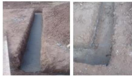
PLANTILLA DE CONCRETO 6CM DE ESPESOR.
